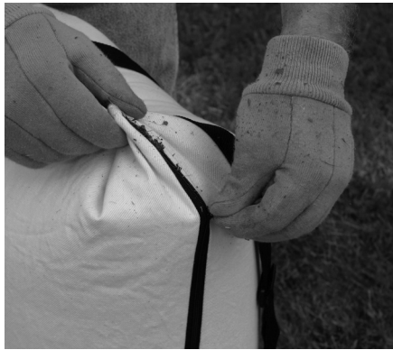
Figure 4-11 : Ouverture de la fermeture-éclair et vidange du sac
